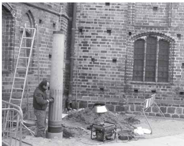
Eine neue Pumpe aus Eichenholz wurde jetzt von einer Schwedter Firma an der Marienkirche aufgestellt. Auch ein Zeichen, dass der Frühling naht.
